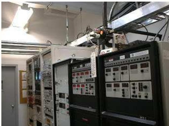
Parte degli apparati dei sistemi satellitari. Si notano degli amplificatori con TWT ( Travelling Wave Tube ) da alcuni centinaia di watt, ridondanti .
