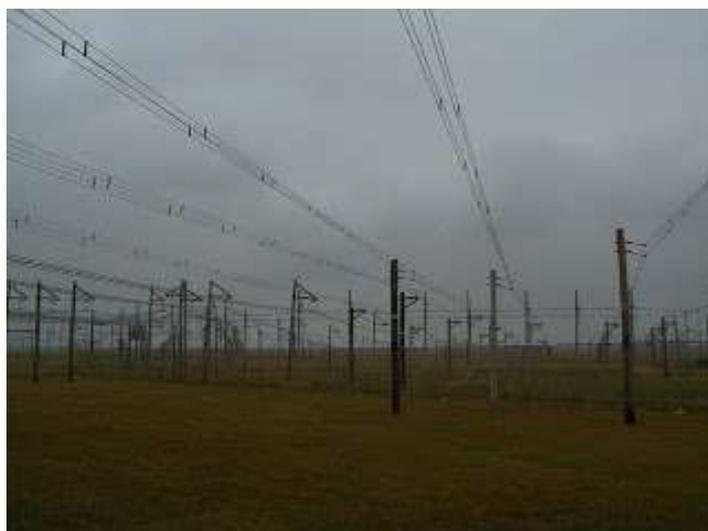
Una delle parti più impressionanti : il sistema di linee di trasmissione bilanciate che partono verso le antenne. Impressionante il numero e la spaziatura di puntamento. Abbiamo potuto vedere nelle etichette all'interno che tra una antenna e l'altra esistevano delle differenze di azimut di pochi gradi ( esempio :  $252^\circ$  e  $255^\circ$ ), segno che le mastodontiche antenne sono ovviamente molto direttive .
