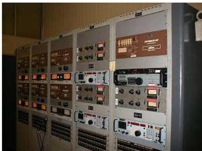
I processori di modulazione ed i ricevitori di controllo
