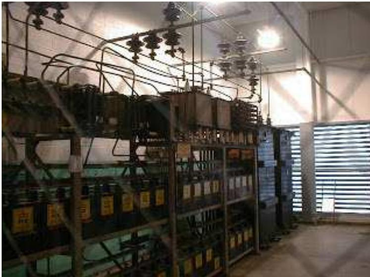
Stadio di accordo di uscita e trasformatore di modulazione . Foto fatte tramite il vetro con all'interno griglie metalliche schermanti .
